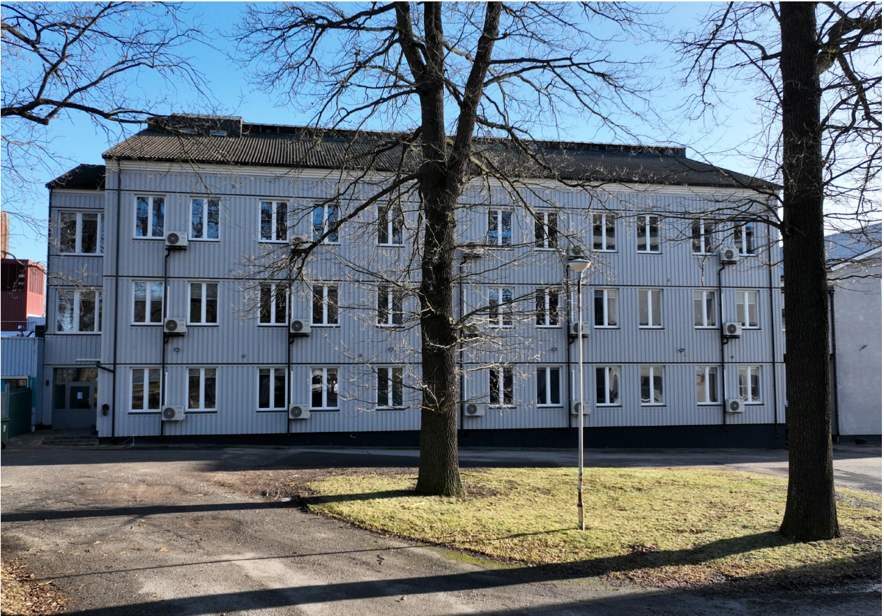
BYGGNAD 6, Innehåller 36 nybyggda kontorslägenheter.
